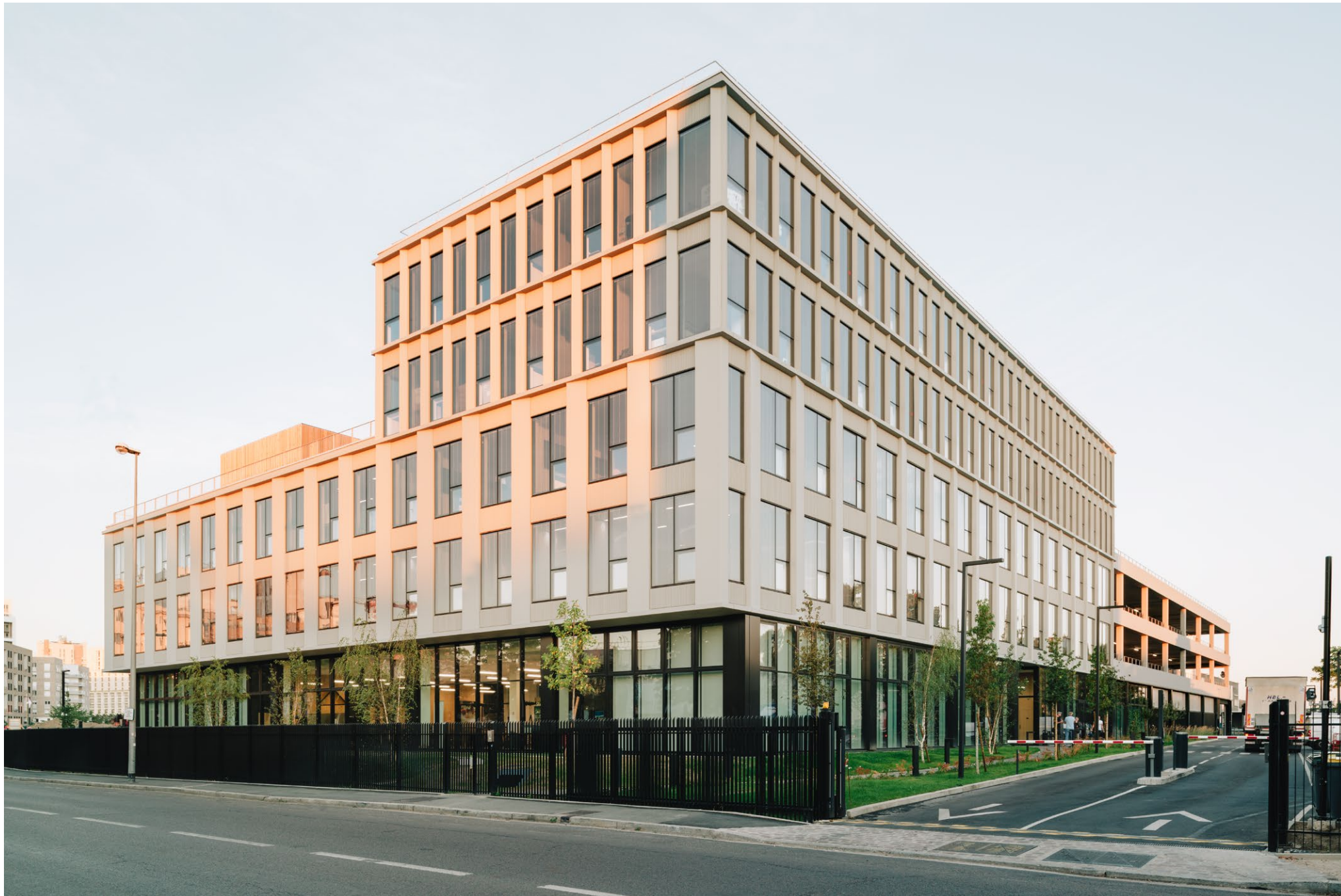
Siège social BALAS, Gennevilliers, atelier FUSO
